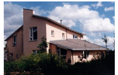
Haus Habermehl, NL-Maastricht
