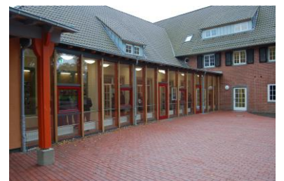
Umbau Schule Benefeld
